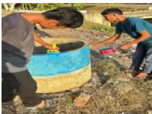
Gambar 1. Proses Pembuatan Bak Sampah
